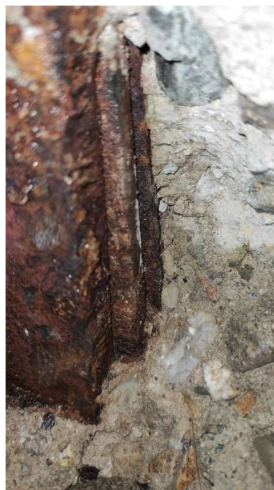
Obr. 5: Detail kotvení na vnějším líci železobetonového věnce – koroze data STP_group
