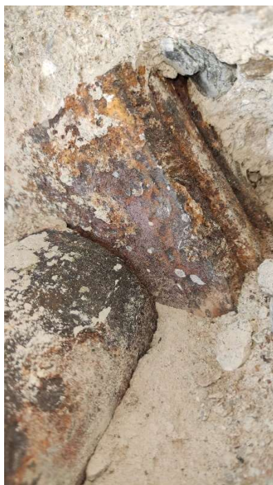
Obr. 5: Detail kotvení na vnějším líci železobetonového věnce – koroze data STP_group
